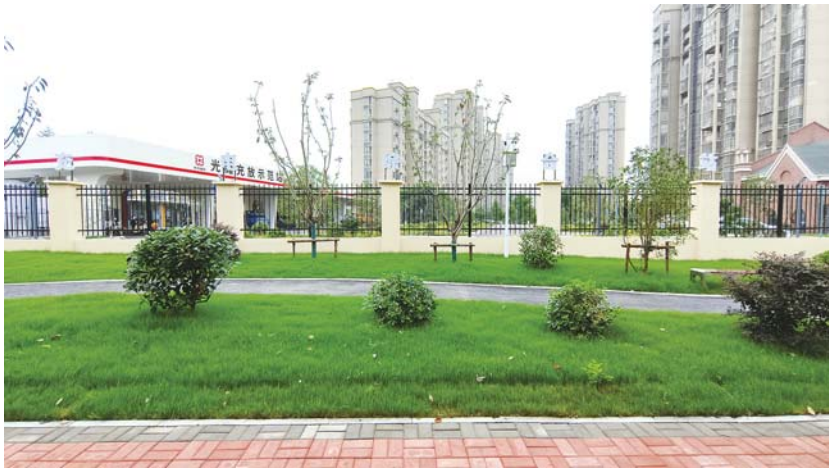
朝阳南路与黄山大道交叉口西北角，实体墙拆除，绿意满目。
