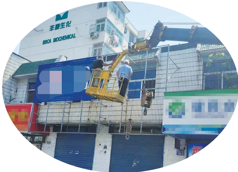
张公山路上,严重遮挡二楼窗户的广告牌正被拆除。
