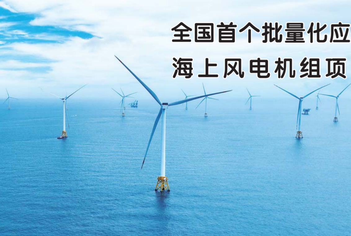
6月19日拍摄的三峡集团漳浦二期海上风电项目现场(无人机照片)。
