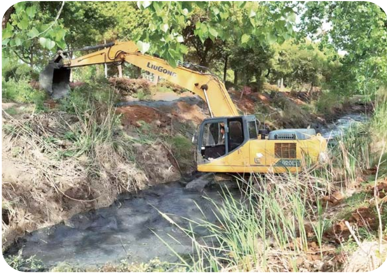
整治黑臭水体现场。
