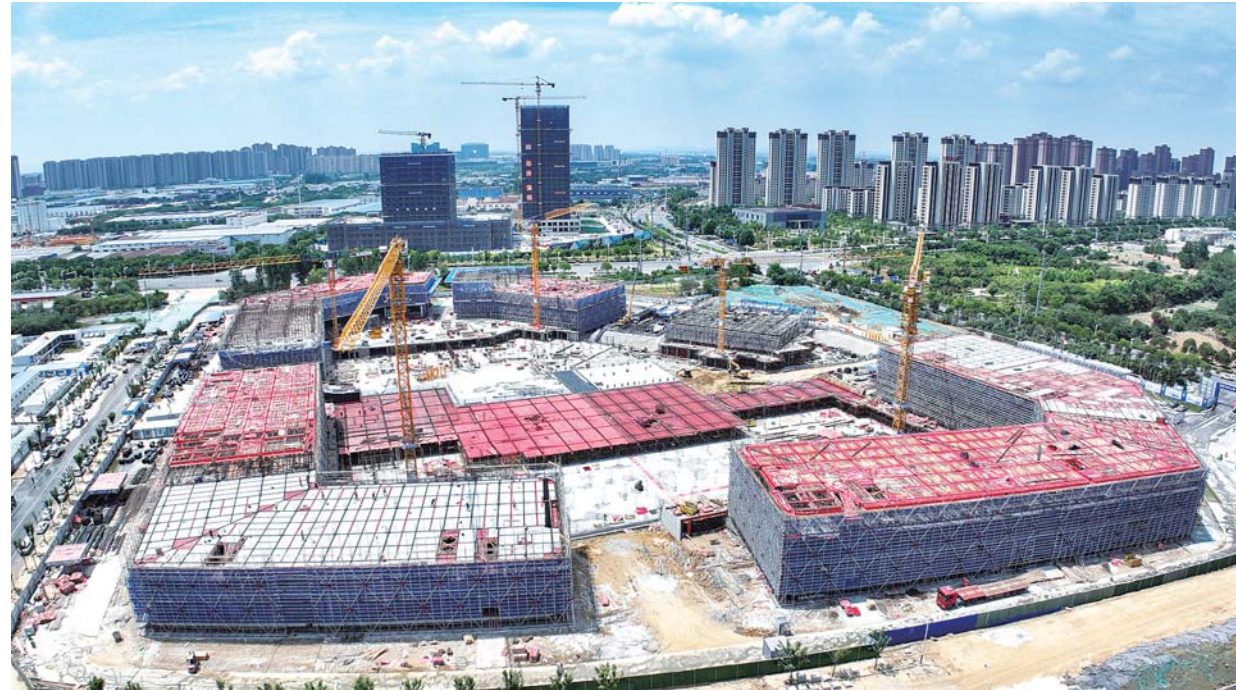
作为中国·蚌埠商业航天产业园D地块项目，禹会空天科技创新产业园项目正处在主体结构施工阶段。
