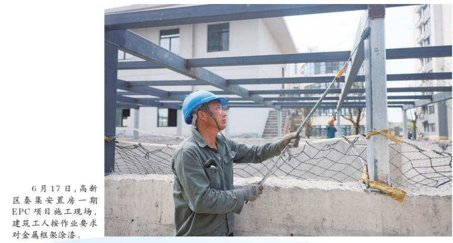
6月17日,高新区秦集安置房一期EPC项目施工现场,建筑工人按作业要求对金属框架涂漆。
