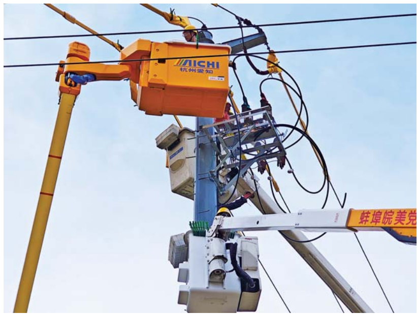
国网蚌埠供电公司供电服务指挥中心配电带电作业班工作人员在进行电路检修工作。
