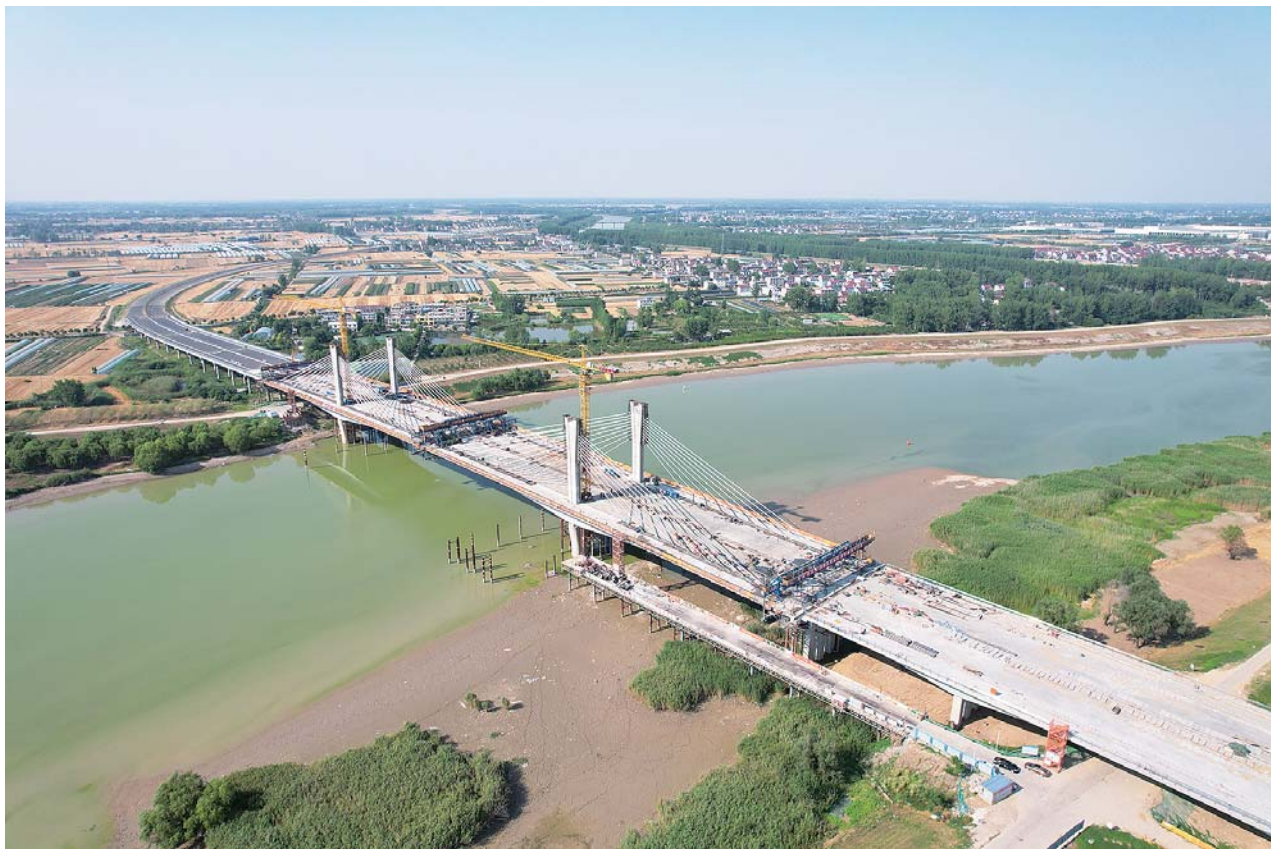
图为正在建设中的涡河八桥。(无人机照片)
