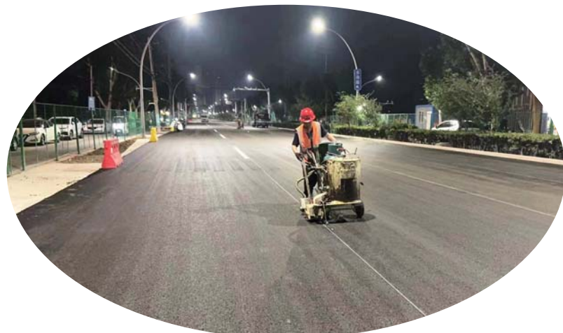
涂山路改造工程施工中。
