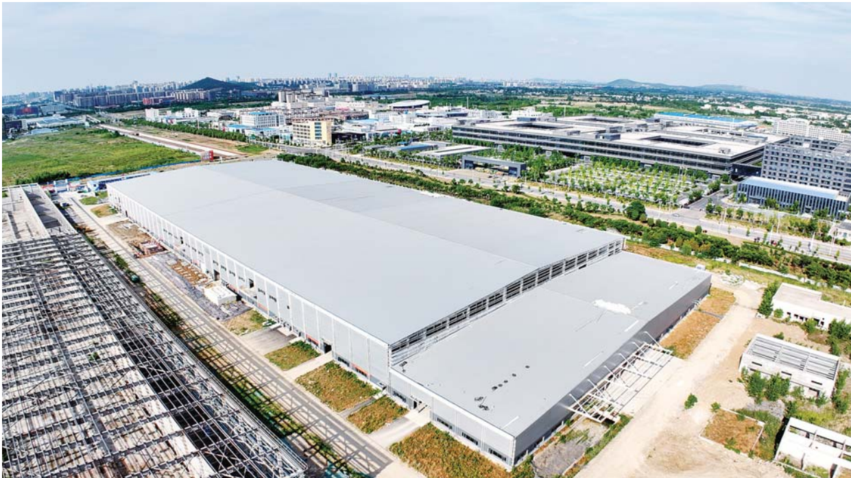
6月11日下午,蚌埠高新区智能制造产业园内,正在建设中的年产400万套新能源汽车玻璃项目。
