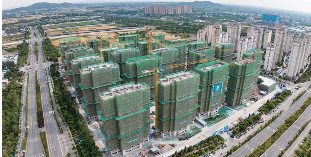
本报讯(融媒体首席记者 陈昂 通讯员 王涛 文/图)本月初,备受社会关注的蚌埠高铁新村安置房项目北区12栋住宅主体结构全面封顶,标志着项目北区正式进入装饰装修阶段。下一步,项目将开展抹灰、外墙保温、外架拆除、涂料、机电等工程施工,项目部将严格进行质量安全管理,确保项目稳步推进。
