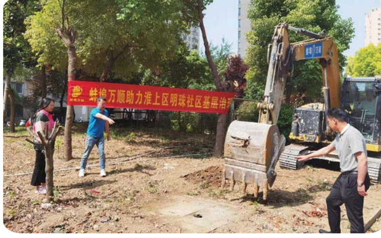
爱心企业现场施工。
