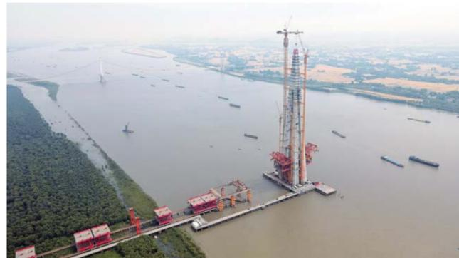
这是5月22日拍摄的巢马城际铁路马鞍山长江公铁大桥4号墩主塔封顶施工现场(无人机照片)。当日,由中铁大桥局承建的巢马城际铁路(巢湖至马鞍山)马鞍山长江公铁大桥4号墩主塔顺利封顶,该主塔为大桥中塔柱,塔高345米,是全桥最高主塔。至此,巢马城际铁路马鞍山长江公铁大桥三座主塔全部实现封顶,即将全面进入钢梁悬臂架设阶段。
