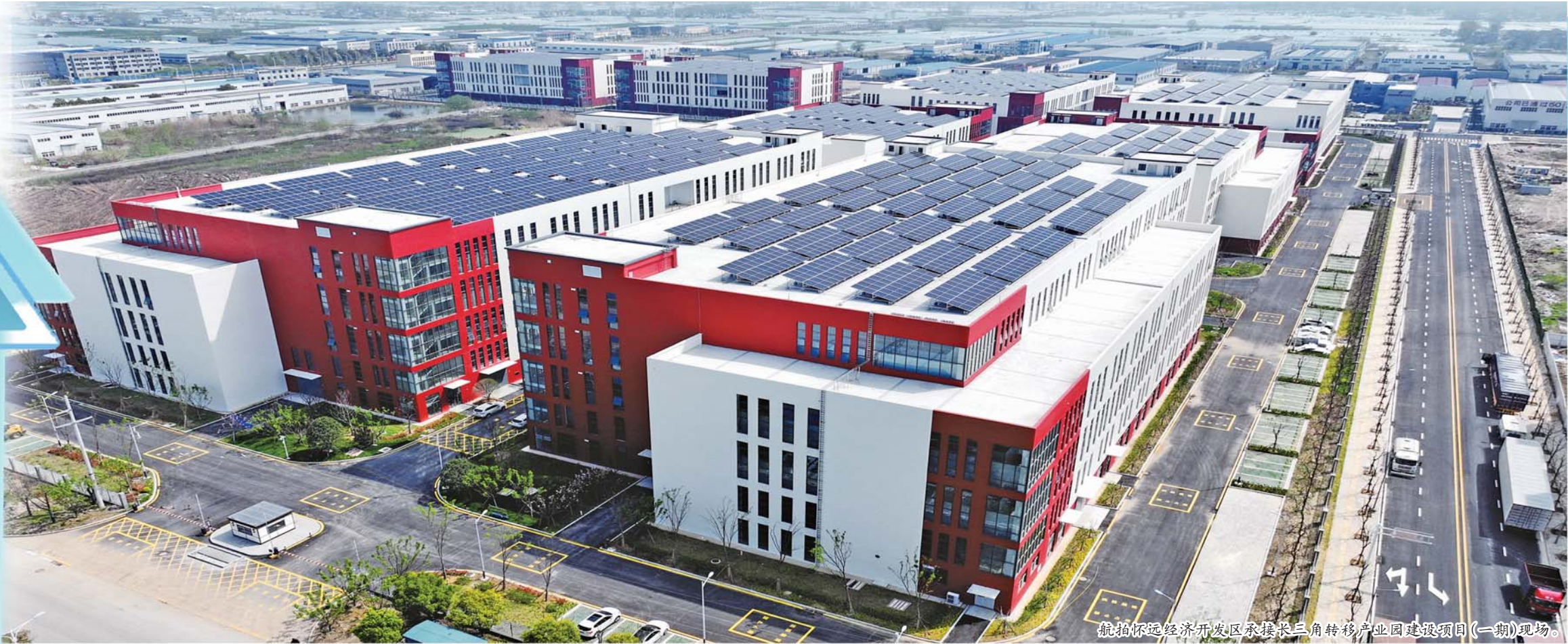
航拍怀远经济开发区承接长三角转移产业园建设项目（一期）现场。
