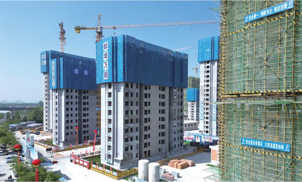
淮上明居东区新建工程建设现场。
