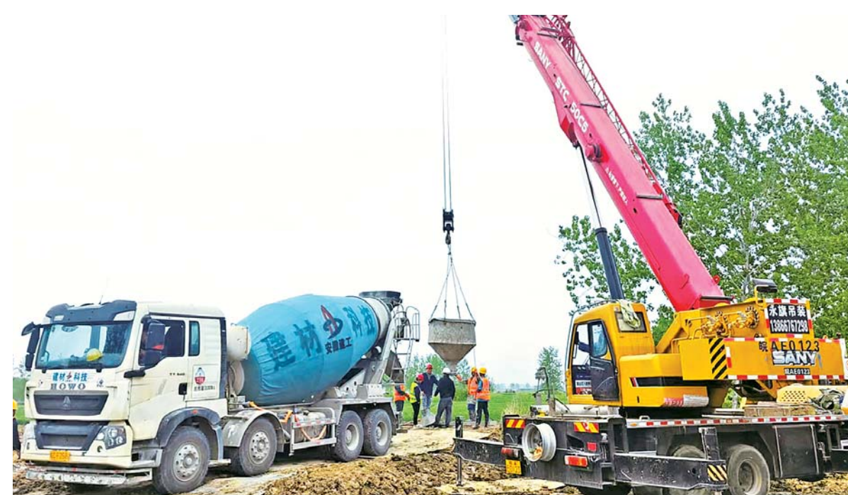
图为项目进行桩基施工
