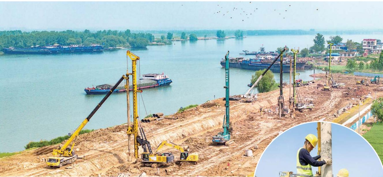
本报讯(融媒体首席记者 陈昂 通讯员 张坤文/图)备受社会关注的蚌埠市黄疃窑综合码头项目目前已完成码头土方开挖32000立方米,码头灌注桩87根。计划2024年5月底完成码头全部灌注桩施工,7月完成码头纵梁施工,12月底基本建成。
