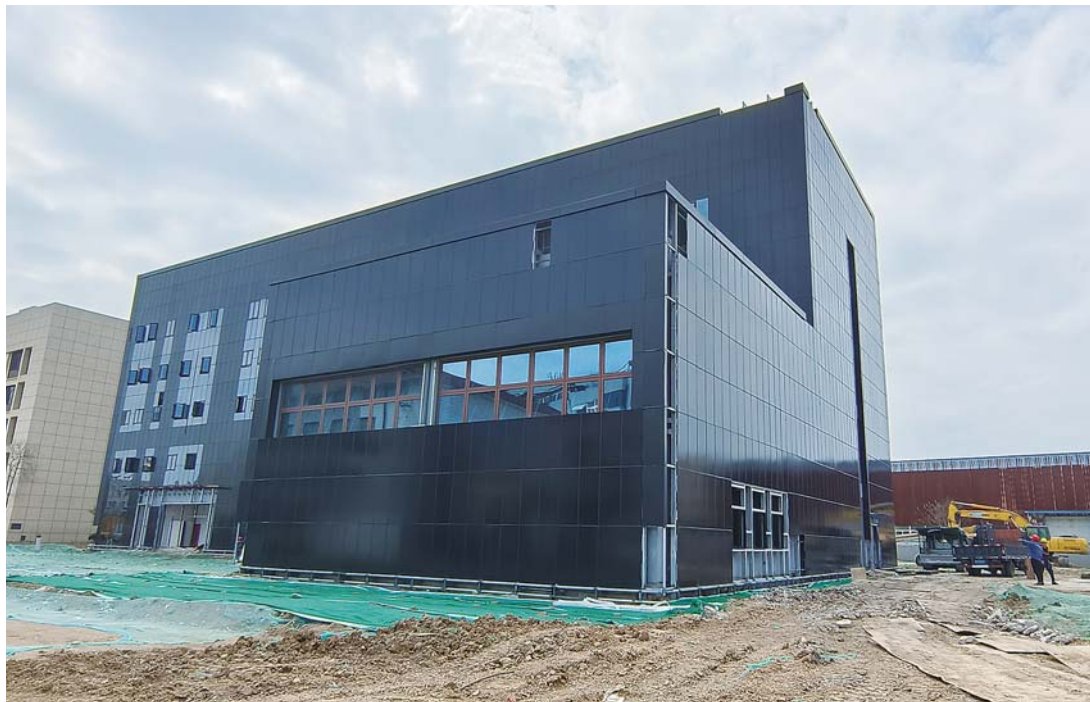
图为国网安徽蚌埠供电公司变电运维用房项目。
