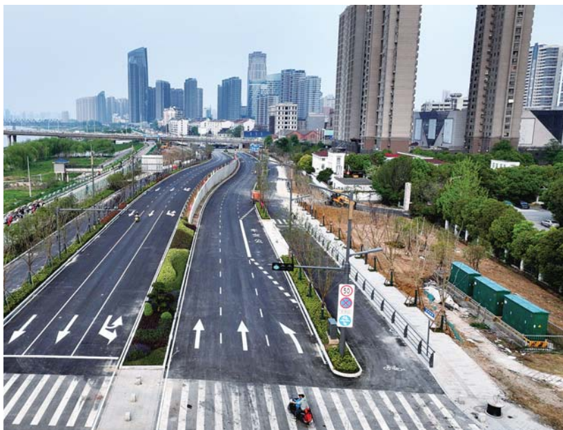
滨河南路三期工程(纬四路-升平街)。
