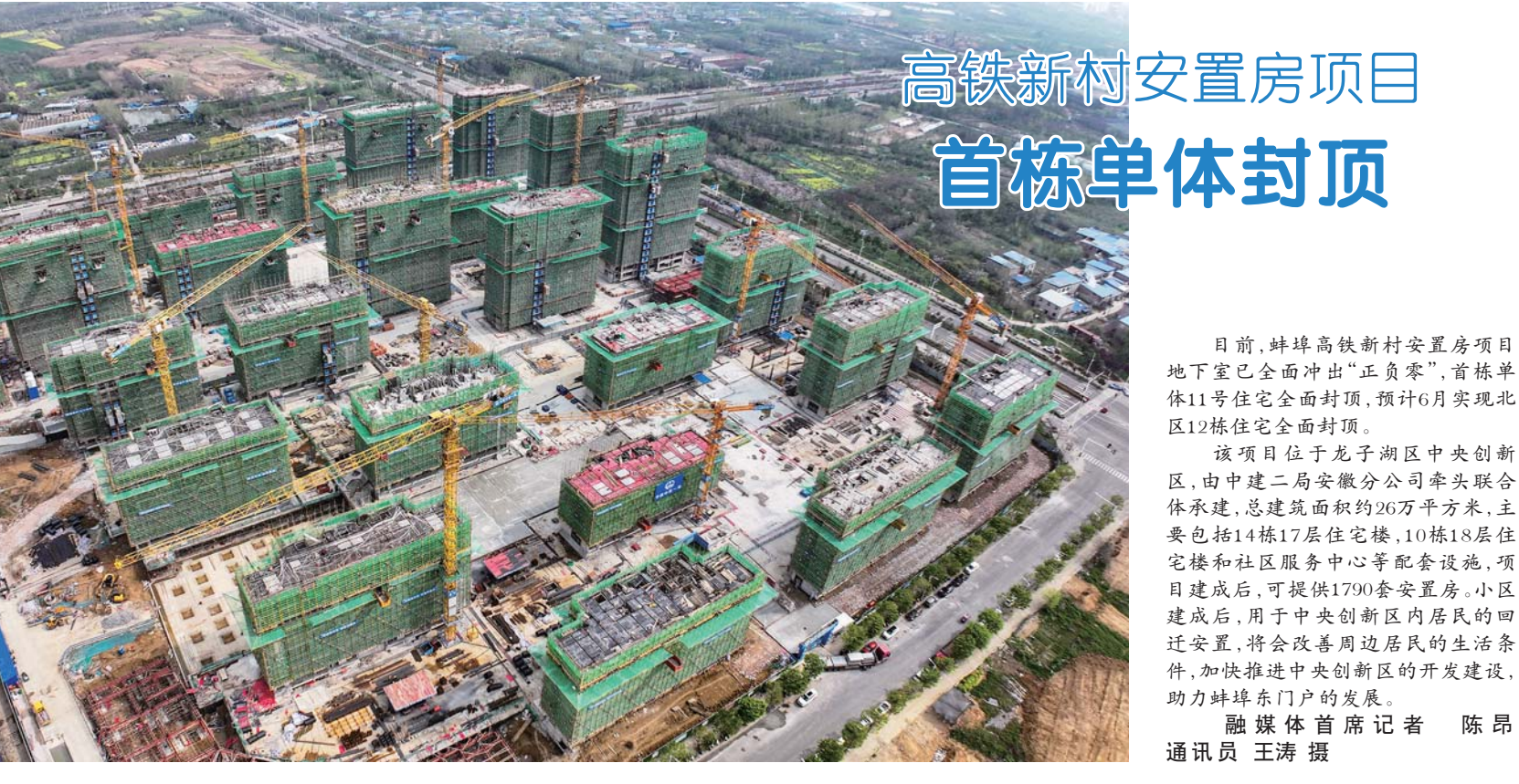
高铁新村安置房项目首栋单体封顶
