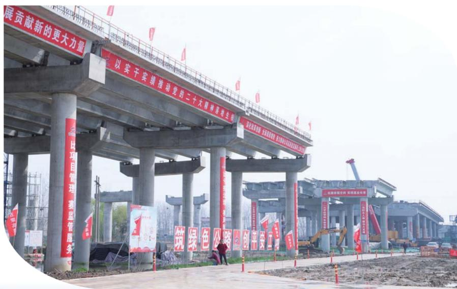
五蒙高速包集枢纽作为本项目控制性节点工程,包含主线特大桥2座,匝道桥8座。截至目前节点桩基工程完成97%;下部结构已完成80%;梁板预制与安装已完成75%;现浇箱梁已完成65%;钢箱梁已全部完成;涵洞已完成80%;路基土方回填完成35%。该节点计划5月底前完成所有下部墩柱及盖梁结构施工;9月底前完成枢纽路基施工。
