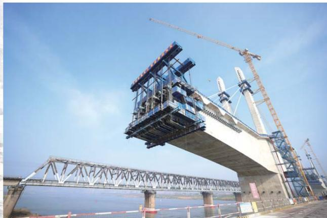
淮宿蚌城际铁路跨淮河矮塔斜拉桥,第三组斜拉索已安装完成,南岸已完成连续梁第13节段,北岸14节段,南北岸正在有序施工14节段、15节段,距合龙还差16节段,预计2024年12月份合龙。
