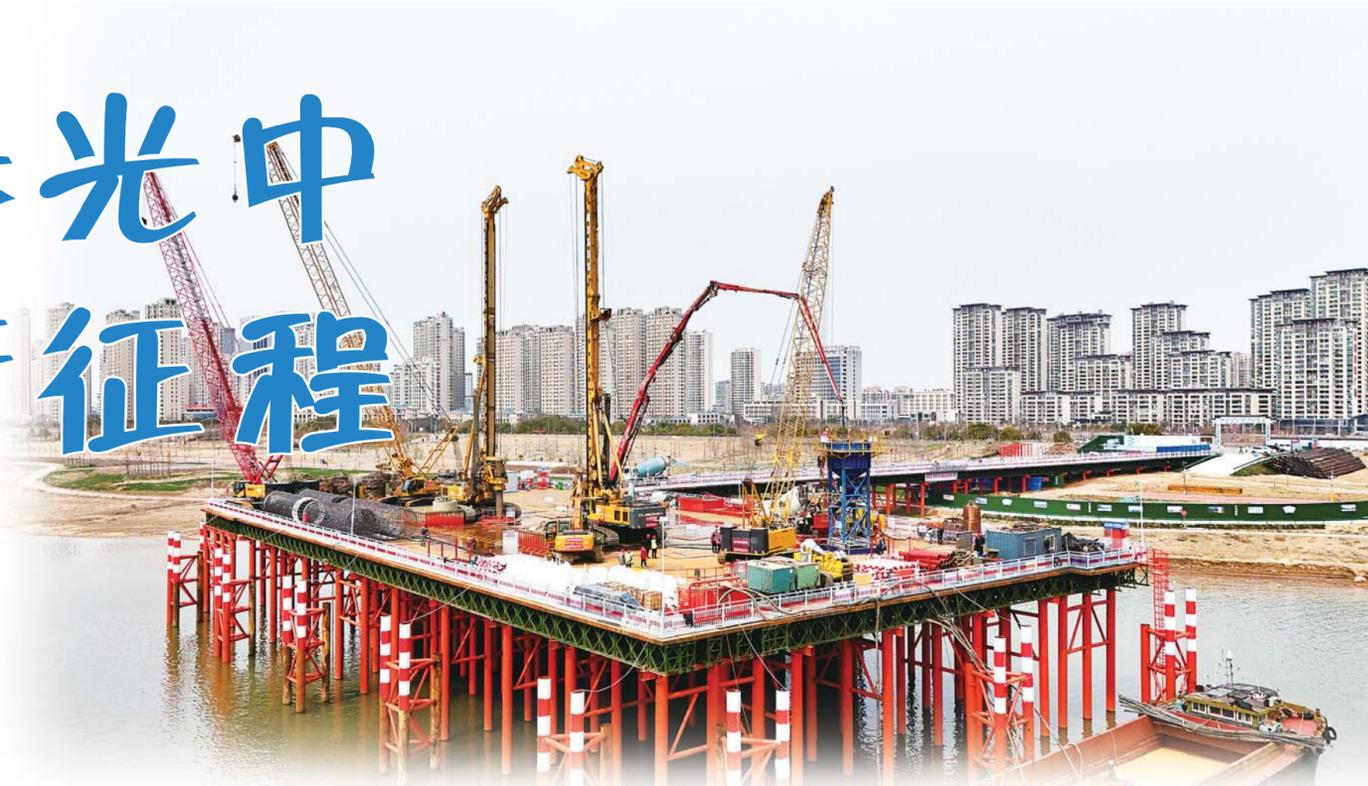
日前,延安路淮河大桥北岸施工现场,施工人员操作工程机械进行首桩浇筑。
