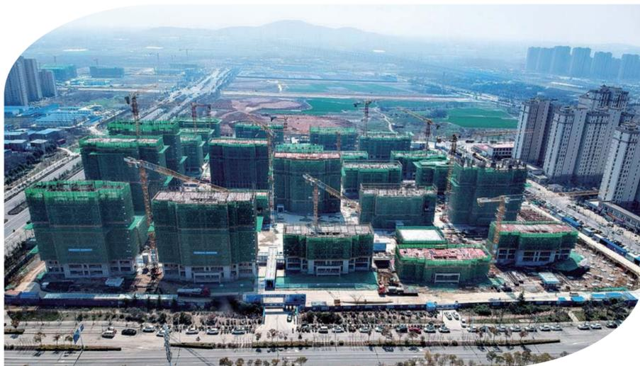
位于龙子湖区李楼乡的蚌埠高铁新村安置房项目开足马力,达产满产,目前北区12栋住宅地下室已全面出“正负零”,首栋住宅将于近日封顶。该项目由中建二局安徽分公司牵头联合体承建,总建筑面积约26万平方米,主要包括14栋17层住宅楼,10栋18层住宅楼和社区服务中心等配套设施。项目建成后,可提供1870套安置房。
