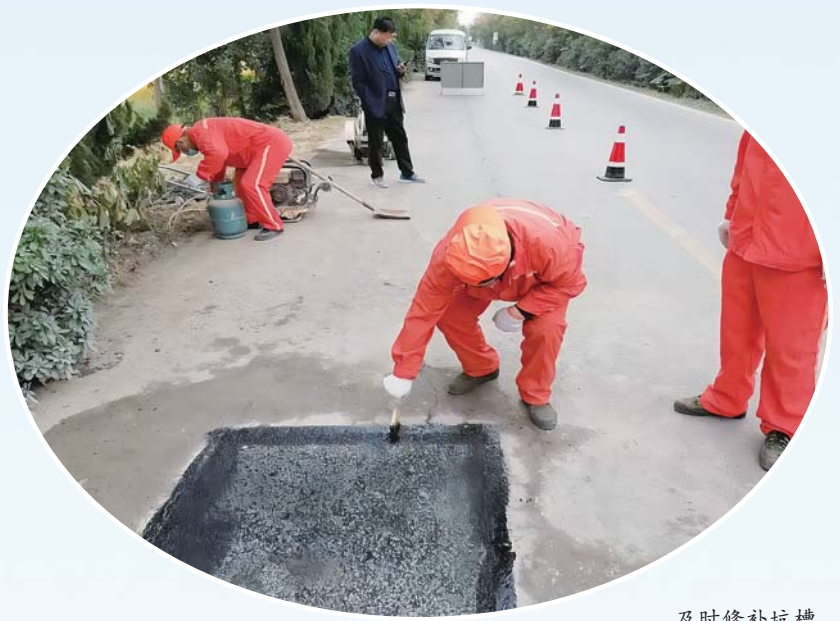
及时修补坑槽。
