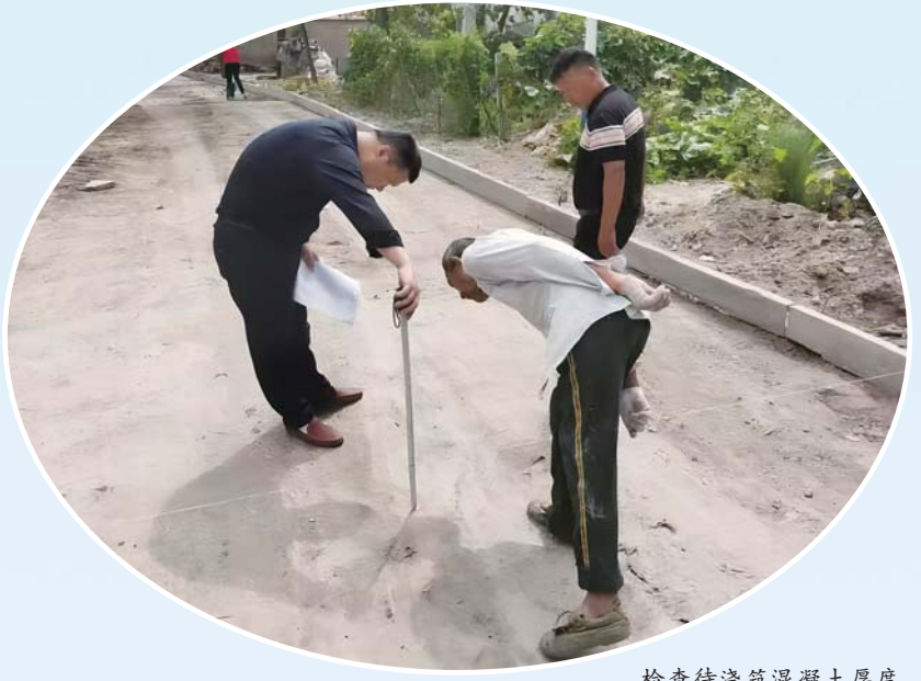
检查待浇筑混凝土厚度。
