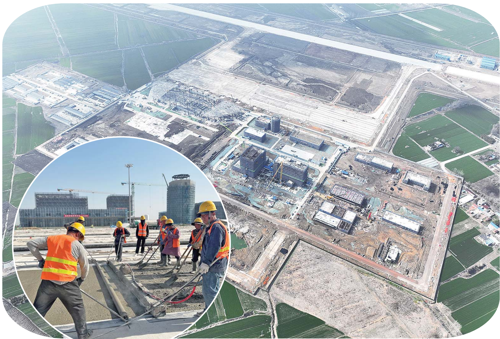
施工人员进行机坪道面混凝土施工。
