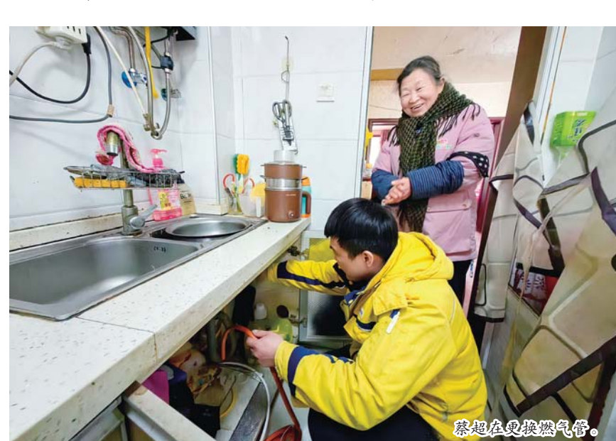
蔡超在更换燃气管。
