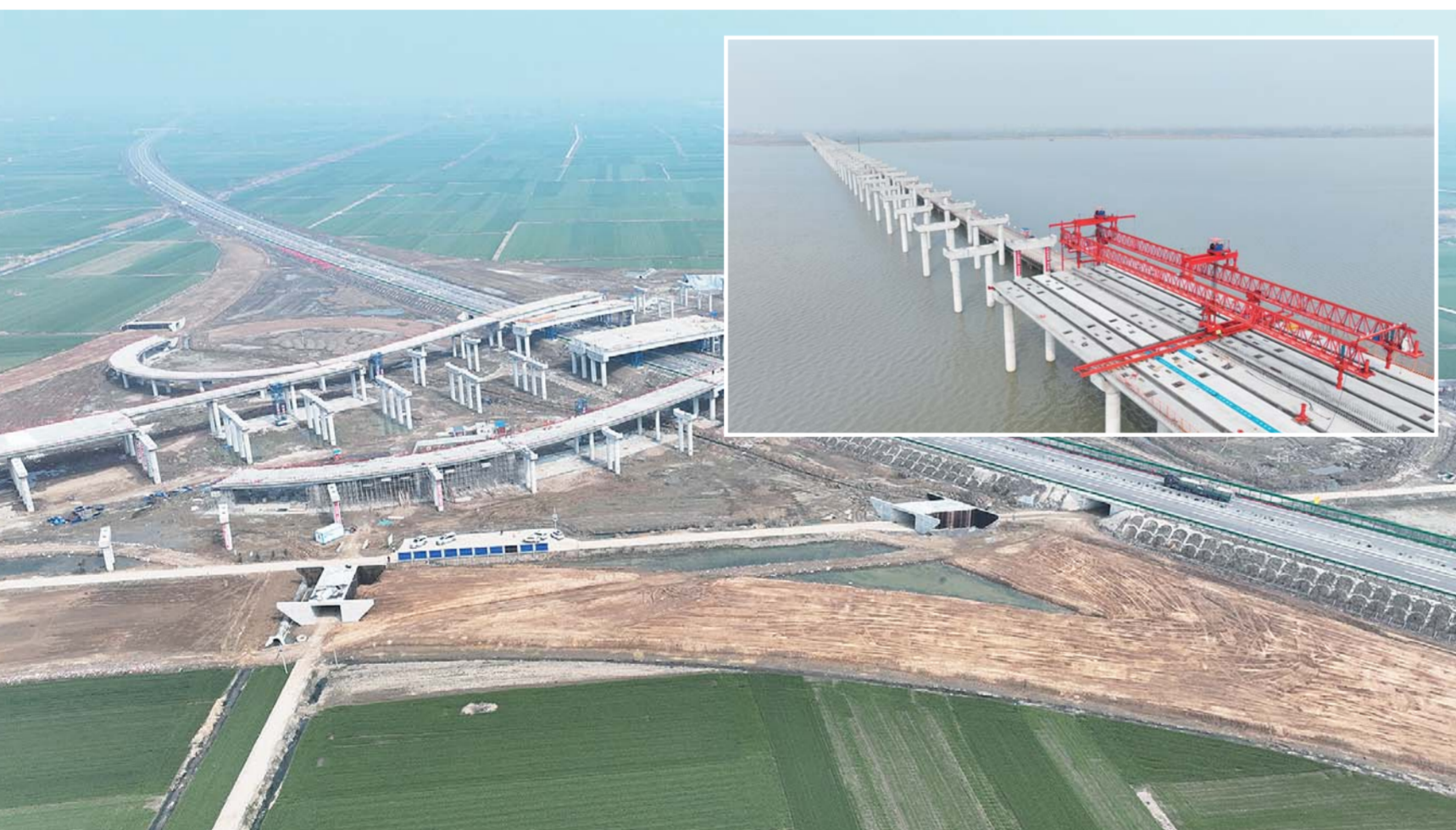
大图: 固镇南枢纽建设加速。 小图: 沱湖特大桥航拍图。
