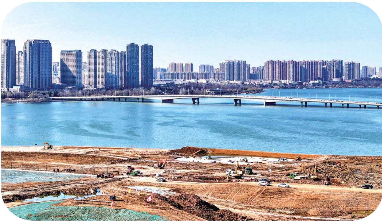
龙子湖东南岸施工现场。
