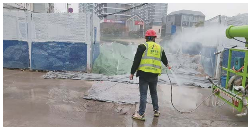
中奥生态施工队在项目现场处理扬尘。
