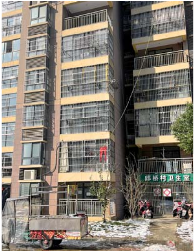
部分安置房小区存在私拉乱接的现象。
