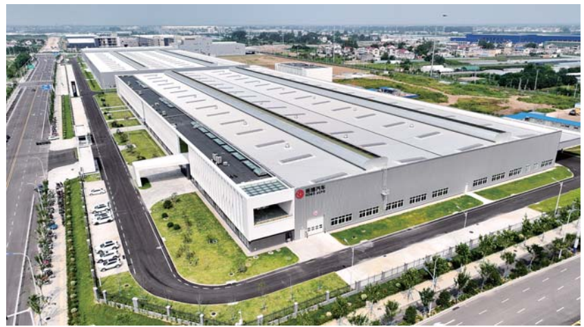
航拍诺博汽车橡塑(安徽)有限公司(橡胶项目)。 融媒体记者 刘晨 摄
