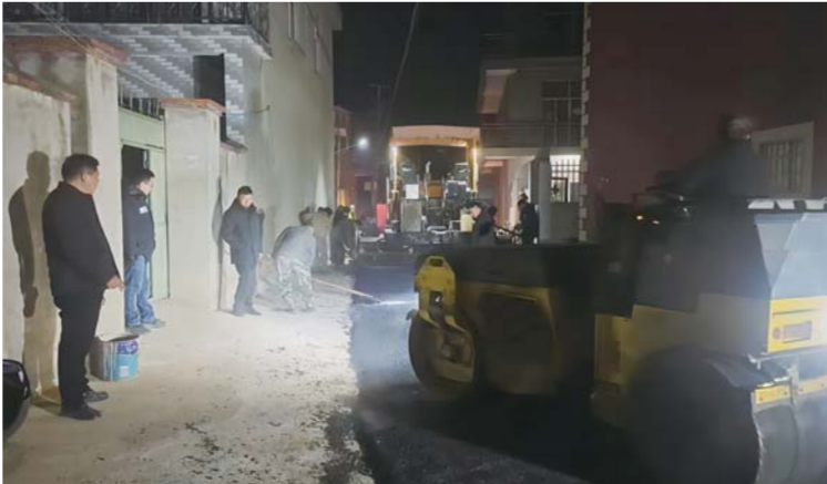
西棚村沥青道路铺设现场。
