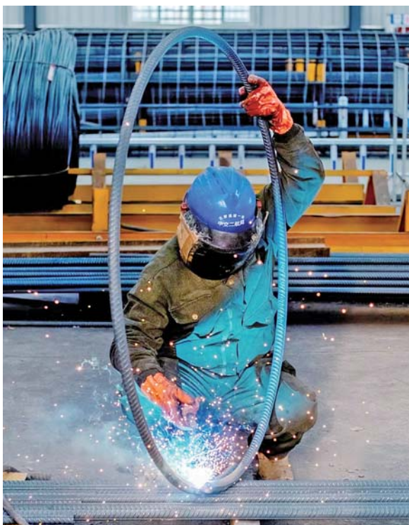
施工人员进行焊接施工。
