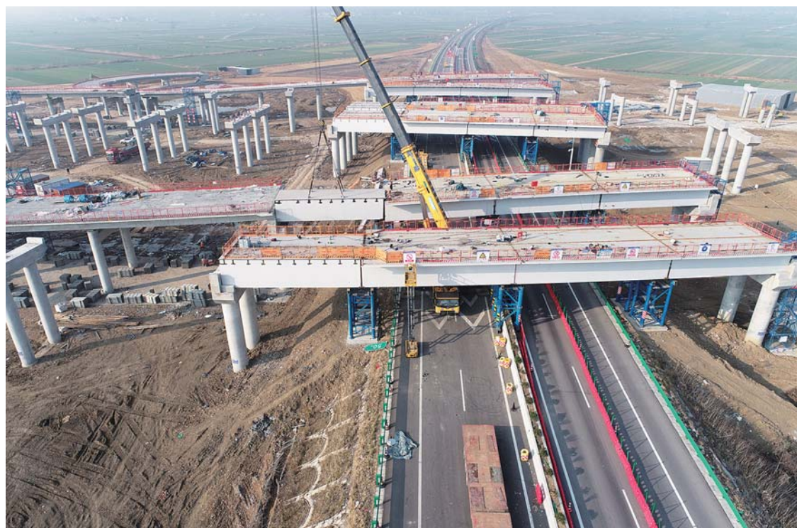
固镇南枢纽跨蚌固高速钢箱梁施工。
