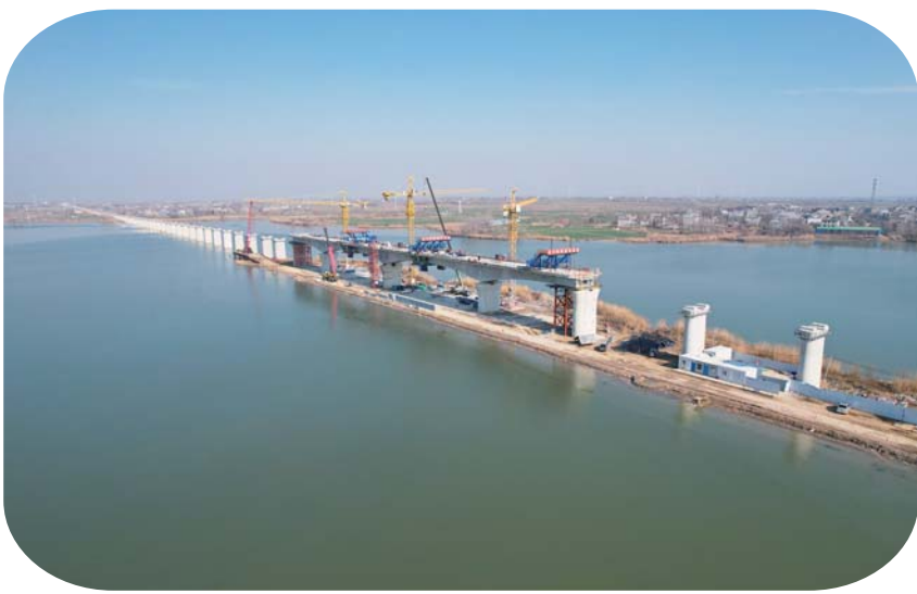
航拍合新铁路天岗湖特大桥施工现场。
