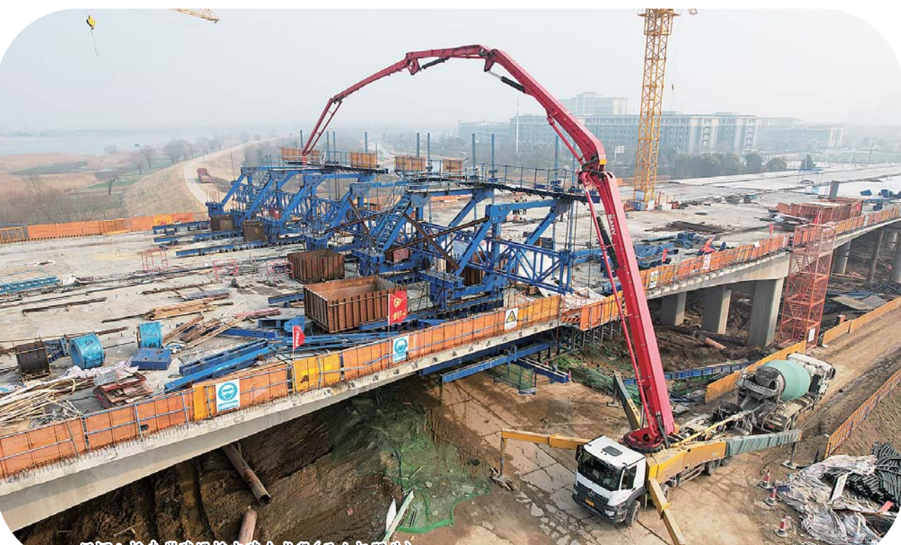
涡河八桥南岸跨堤桥中跨合龙段（无人拍照照片）。
