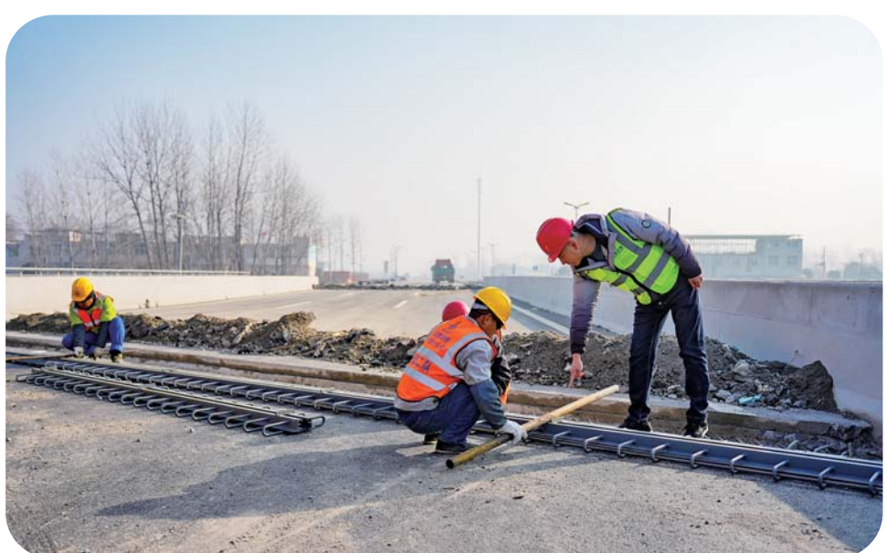
参建人员抢抓工期,为项目月底完工通车做最后冲刺。
