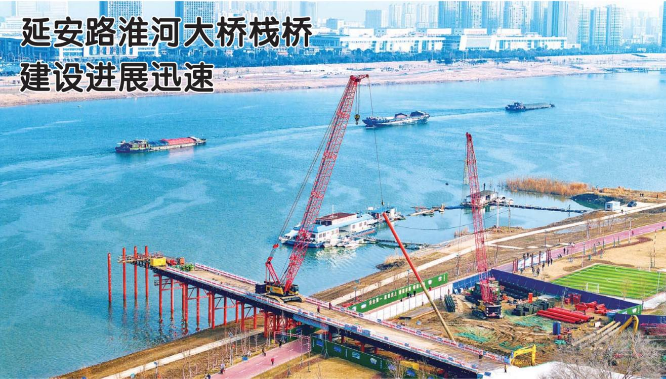
延安路淮河大桥及接线工程南岸栈桥自去年12月21日施工以来,目前共完成钢管桩打插41根1120米,贝雷梁安装11跨115.7米,桥面板安装11跨115.7米,护栏安装231.4米(双侧)。
