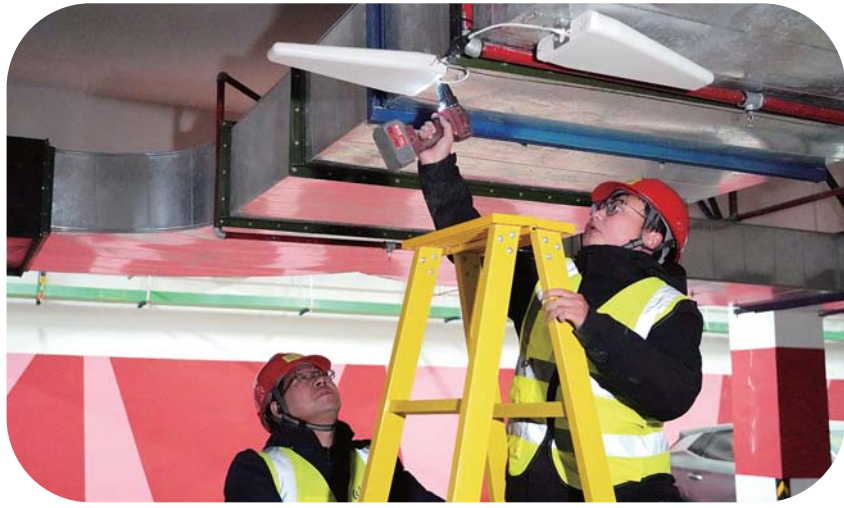
日前,蚌埠移动技术人员在小区室内网络信号盲区区域,添加、优化4\5G通信网络设备。
