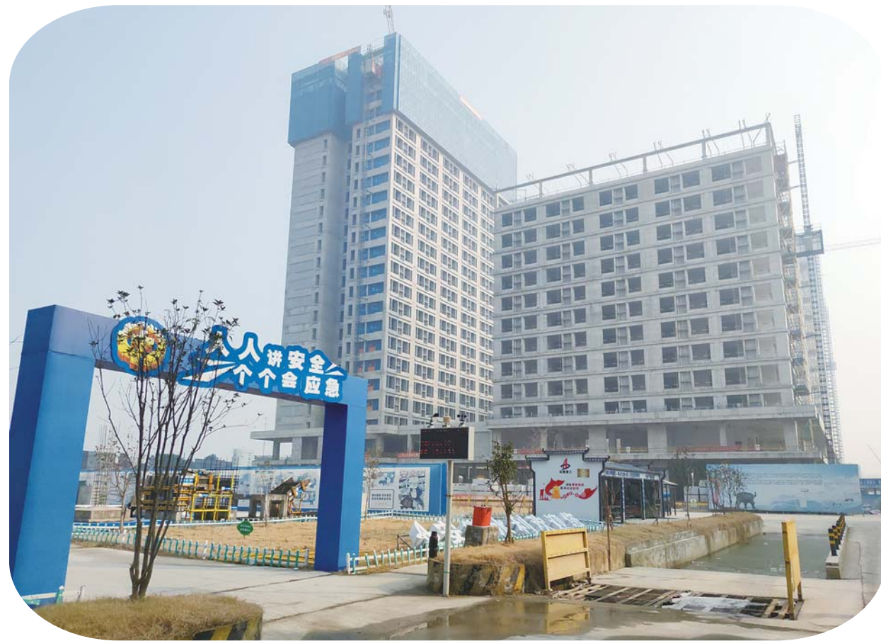
中国传感谷保障性租赁住房项目正在加紧建设。
