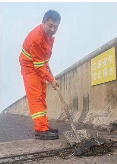
养护人员正在清理桥梁伸缩缝。
