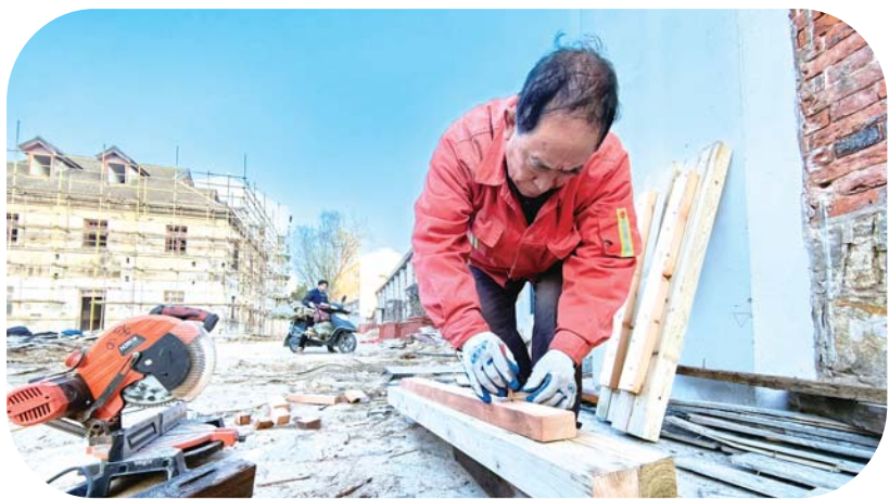
图为修缮现场。
