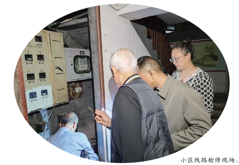
小区线路检修现场。
