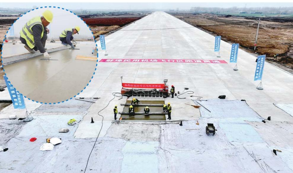
12月12日,位于怀远县泥河镇滕湖村的蚌埠民用机场建设现场,随着最后一块道面铺装作业完成,飞行区跑道全线贯通。该机场飞行区占地约129.6公顷(1944亩),运行指标为4C,设置机位11个,其中近机位6个,飞行区跑道总长2600米。据蚌埠民用机场工程部部长汪俊杰介绍,自2022年10月飞行区工程开工以来,历时一年跑道工程顺利贯通,标志着飞行区主体工程顺利完工,同时,他们还同步开展了飞行区配套工程施工,预计在2024年5月全部施工完成,这将为下一步试飞、校飞做好准备工作。
