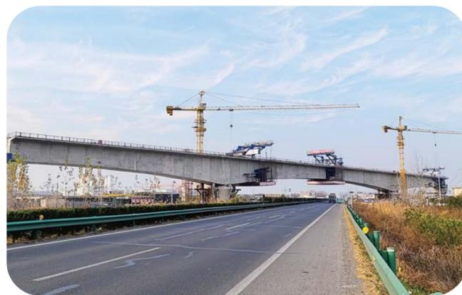
合新高铁怀洪新河特大桥跨G104国道125米悬臂连续梁合龙现场。
