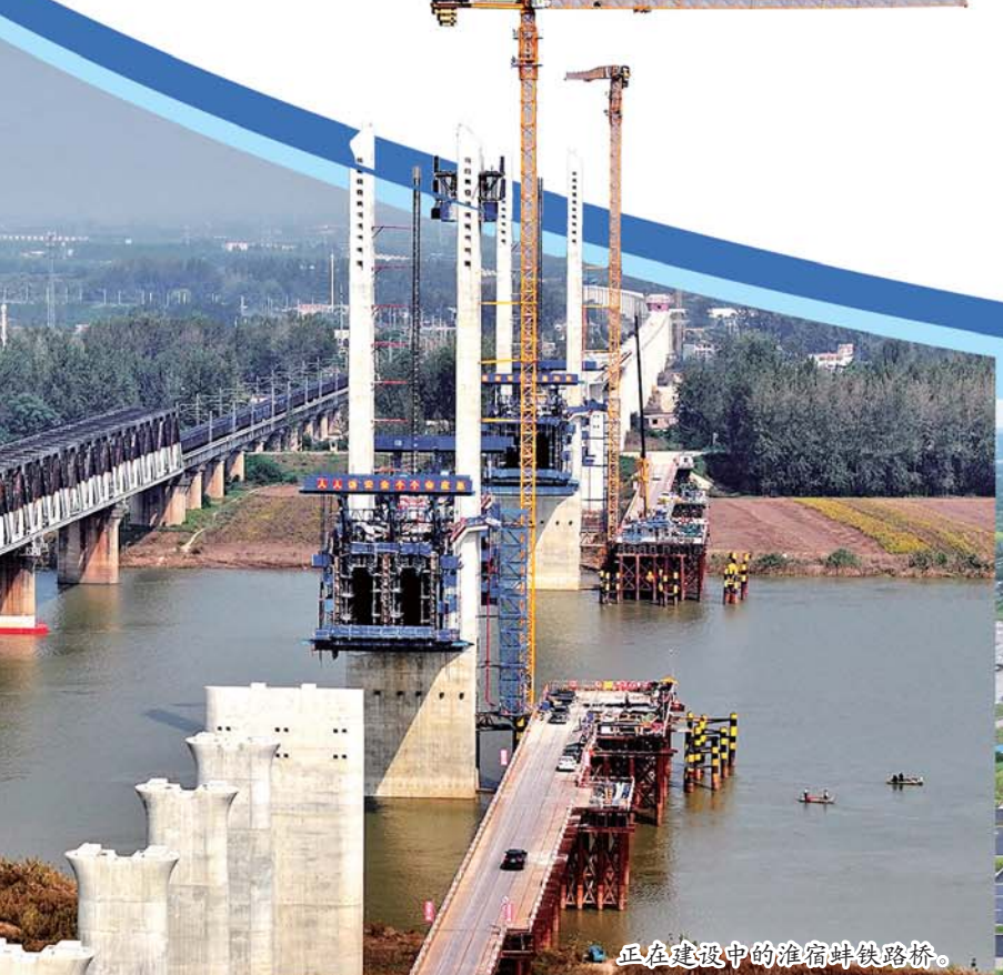
正在建设中的淮宿蚌铁路桥。
