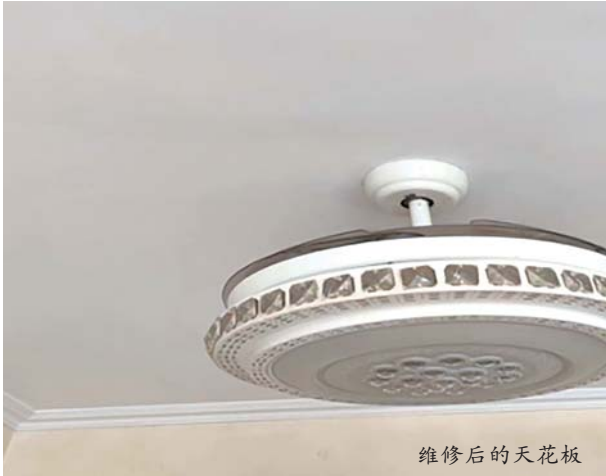
维修后的天花板
