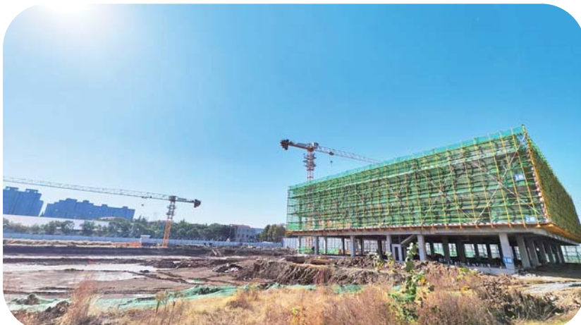
印象湖畔苑项目在分阶段办理施工许可的助力下,比原计划提前一个多月完成了S1号楼的封顶。
