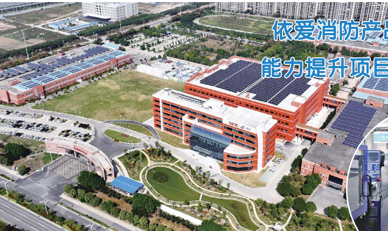
日前，依爱消防产品研发生产能力提升项目(一期)顺利投产。项目分两期建设，其中一期投资2.3亿元，建成后可实现消防报警产品部件年产量1600万只，控制器年产量64万台，气体灭火产量1.8万台(套)，预计可新增年销售收入10亿元，税收约4000万元。
