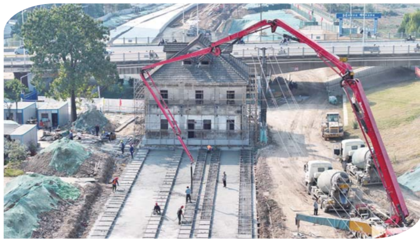
施工人员在铺设位移轨道，进行水泥混凝土浇筑。
