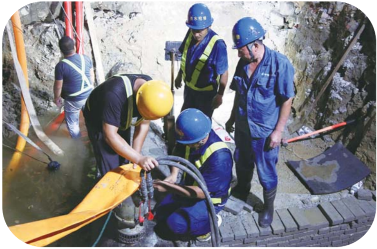
施工人员连夜进行管网升级改造工作。
