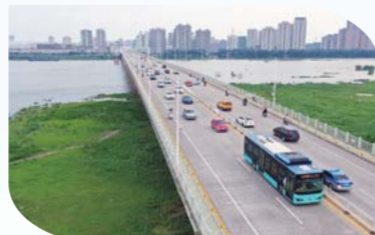
朝阳路淮河公路桥
