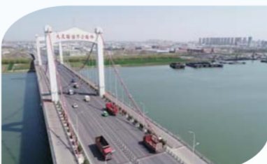
大庆路淮河公路桥
