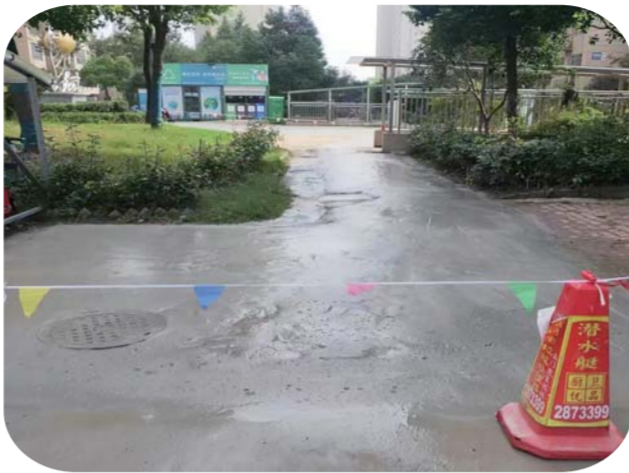
铺设后的水泥路面。
