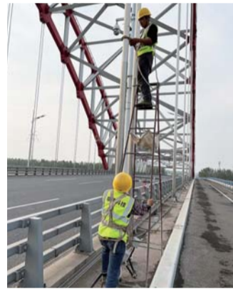
工人们正在安装传感器。
